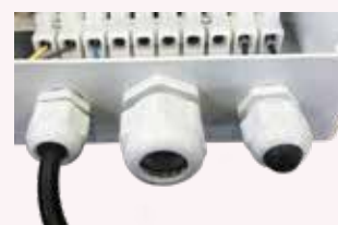
Kabelverschraubungen in 3 verschiedenen Größen
