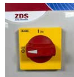
Hauptschalter: mit Verschluss zum Schutz.
