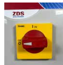
Hauptschalter: mit Verschluss zum Schutz.
